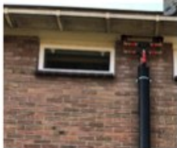
Leiding over gevel of door de woning
